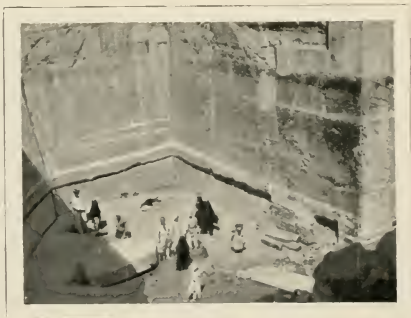
FIG. 79. — LE PLANCHER ET LA CUVE DE LA PYRAMIDE INACHEVÉE A ZAOUÏYÉT-EL-ARYAN. (Cliché Oropesa.)
